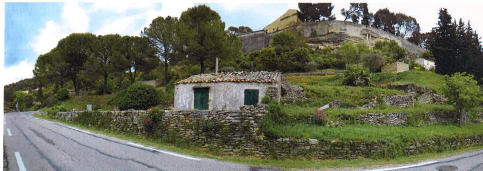
Vue actuelle depuis la RD57 : enchaînement de murs en pierre sèche, terrasses, cabanon et château
